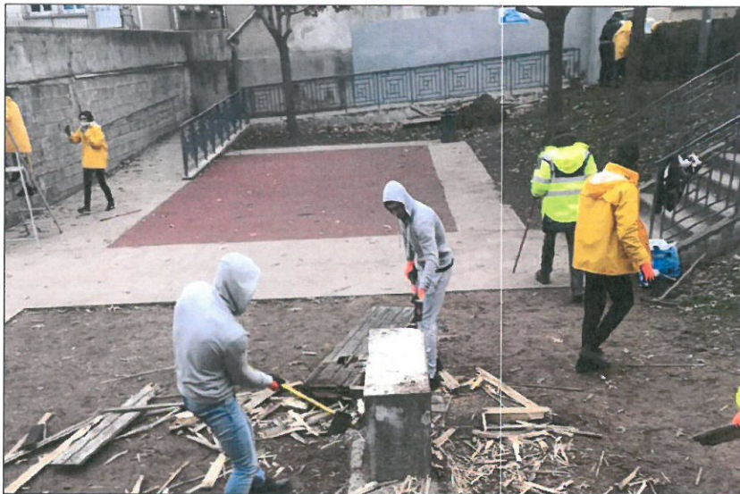
■ Les jeunes travaillent sur le chantier les week-ends et pendant les vacances scolaires. Photo Josette GENTE
